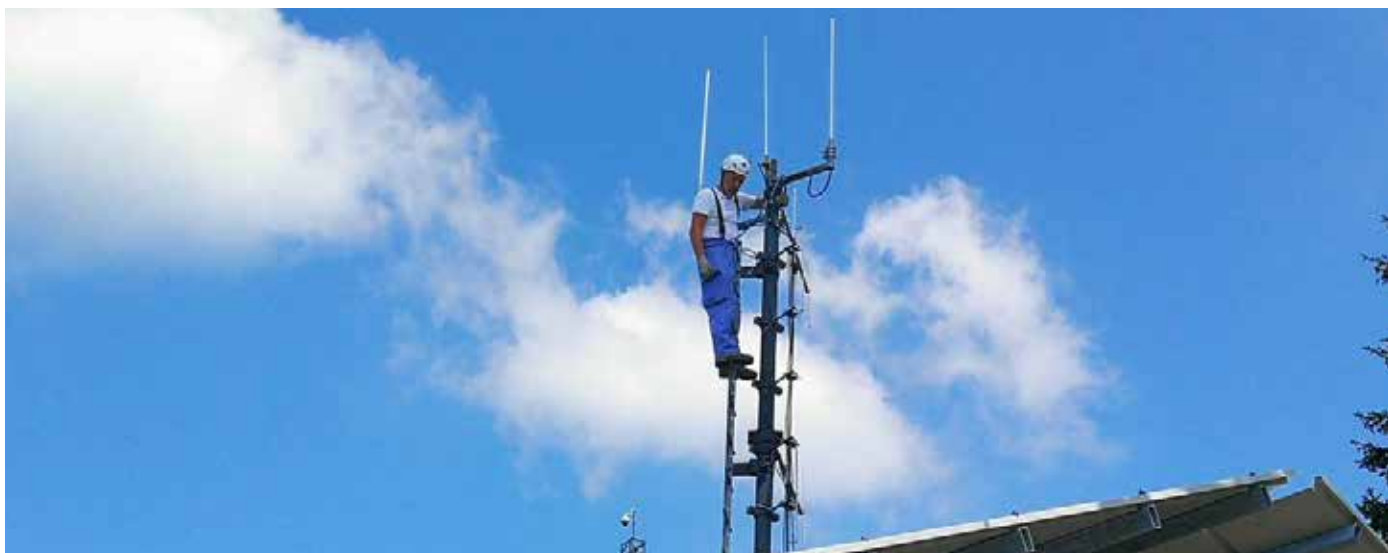
Preparazione del ponte radio
