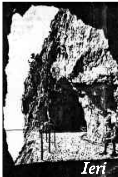
Il tratto di strada compreso tra la 10° e l'11° galleria
