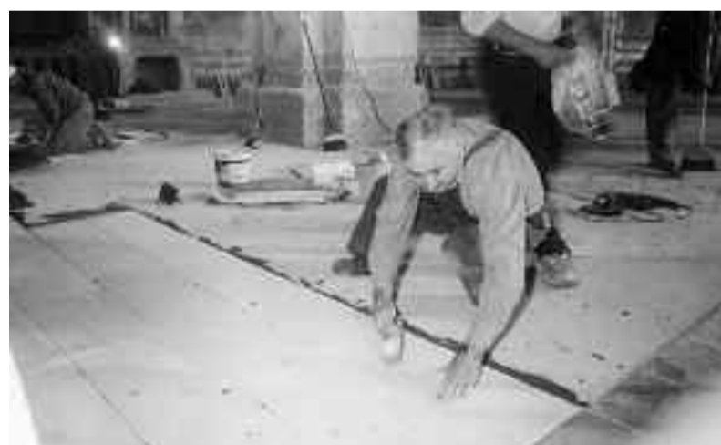
Mario Ferrolì e Antonio Bergamasco posano le piastrelle nella Chiesa di Luizi Călugăra (Romania).
