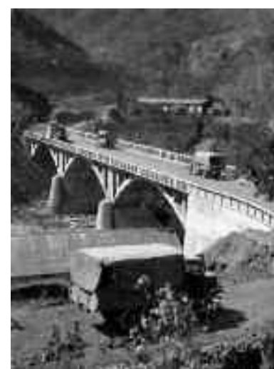
Ponte sul Tacazzé, 1938. Da Asmara a Gondar.
