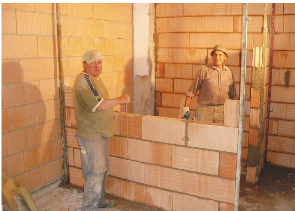
Lavori di ristrutturazione del Soggiorno Alpino di Costalovara (BZ). Archivio ANA Pordenone.
