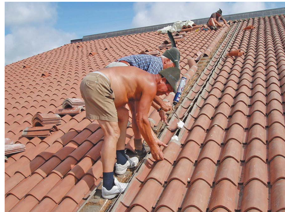
Gli Alpini di Pordenone rifanno il tetto dell'Asilo del Sorriso a Rossosch in Russia. Archivio ANA Pordenone.
