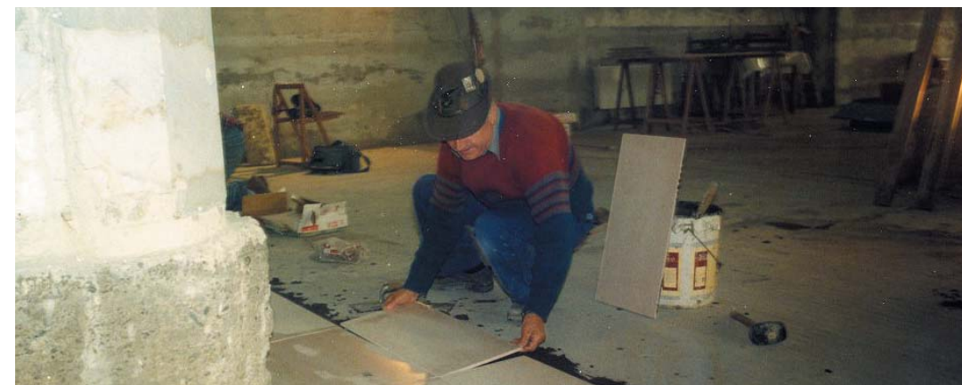
Posa dei pavimenti per la Chiesa dei Frati a Luizi Calugaro (Romania). Archivio ANA Pordenone.
