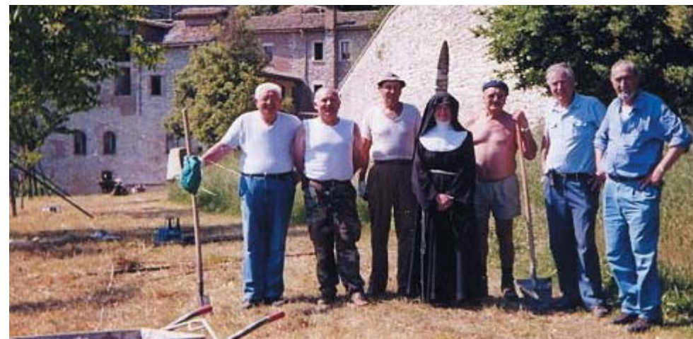
Costruzione di parte del recinto di tutta l'area del Monastero di San Girolamo delle Suore Clarisse Benedettine di Gubbio. Foto con la superiora a lavori ultimati. Archivio ANA Pordenone.
