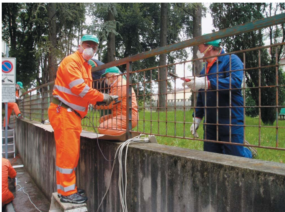
Intervento di manutenzione e pittura delle cancellate del recinto dell'Ospedale Civile di Pordenone. Archivio ANA Pordenone.
